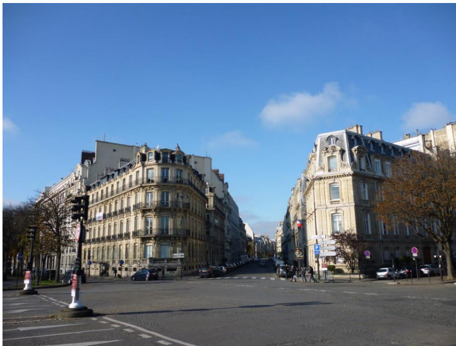
整然としたパリの街(オスマン風建築物と見通しの良い通り)
